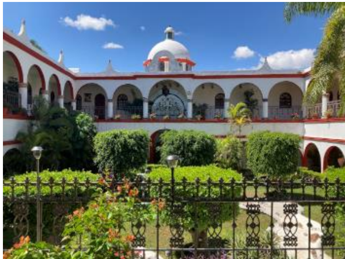
Foto 9: Remodelada la antigua hacienda Cárdenas
