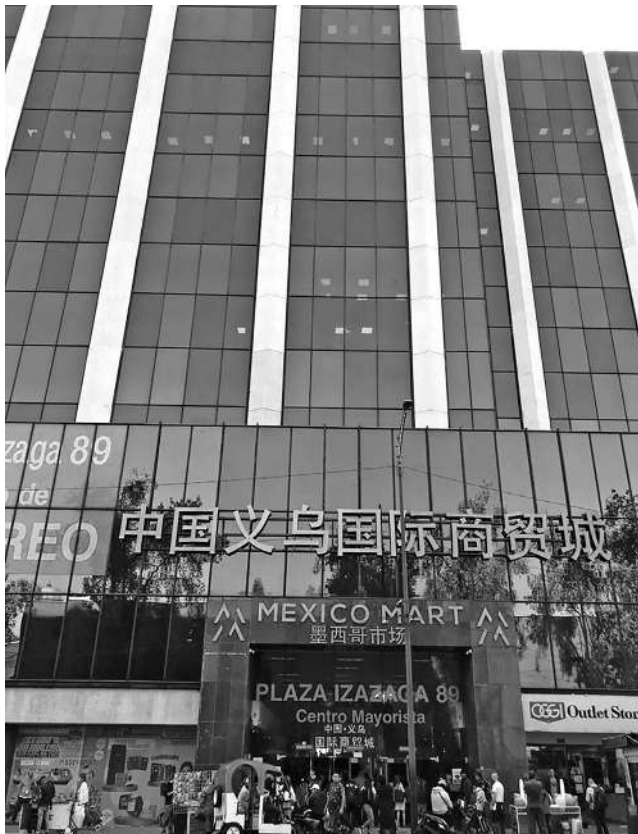
Foto 6: Fachada de la plaza de Izazaga 89
