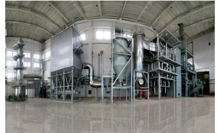
Fábrica de eliminación de los residuos peligrosos
