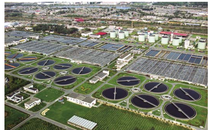
Planta de tratamiento 7 de los aguas residuales
